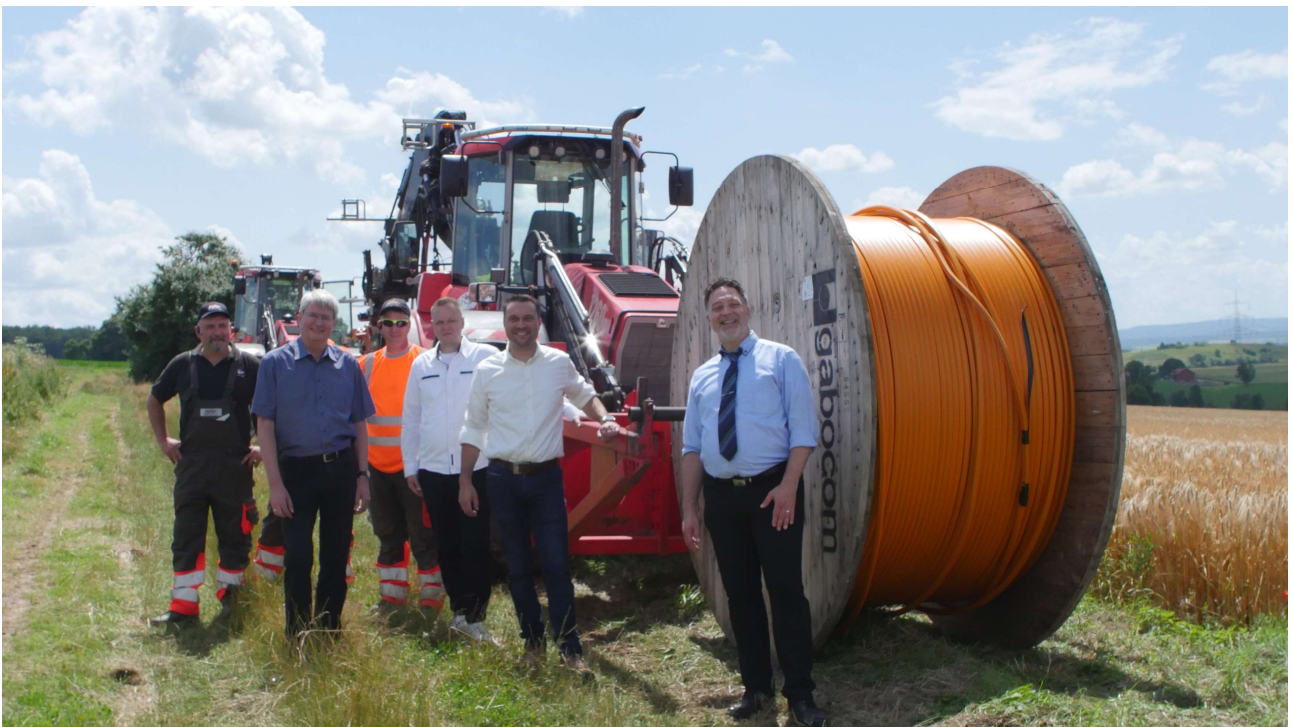
Eine Vorstellung des Kabelpflugs, mit dem die Leerrohre in der Gemeinde Hofgeismar verlegt werden (v.l.n.r. Gustav Keßler, Peter Nissen, Markus Schaumburg, Torben Busse, Oliver Brunkow).
